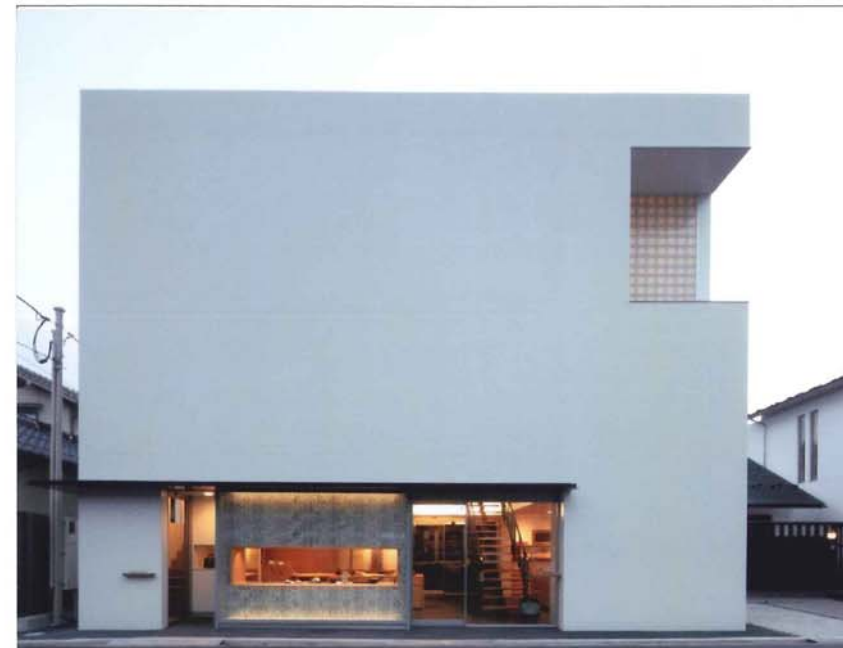
1階呉服店、2階質屋とオフィス、3階 フリースペース(ギャラリー等)で構成された新店舗の外観表現 足元の賑わい、老舗店の確かさ、ガラスブロックのグリッドパターンによるファサード構成
