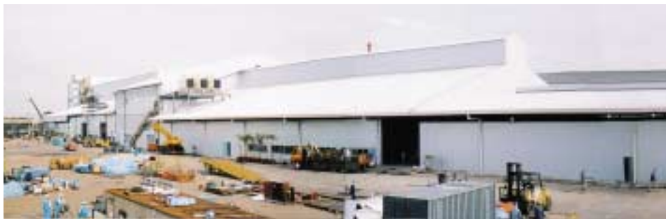
竣工したパネル3号炉棟
