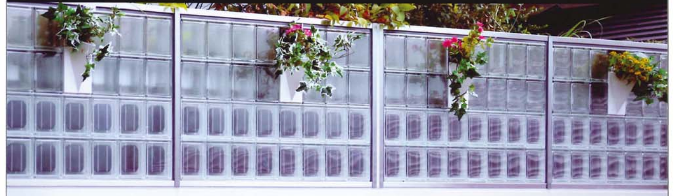
GBにソーラーパネルを内蔵した太陽光発電GBとプランターがメタルジョイント工法により組み込まれている
