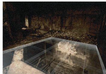
かつて床があった場所に、【床ガラス】を敷くことで、ただ抜け落ちていた場所が地下と断面的に繋がる場となる。
