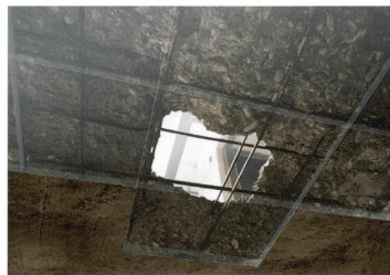
風化によって崩れた部分に【フロートガラス】を用いる。時間の痕跡をありのままの姿を残しながら修復し、補強する。
