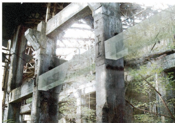
耐蝕性・耐久性に優れた【ネオパリエ】を梁として置換することで建築物を支えながら光は乱反射し、空間を色付ける。
