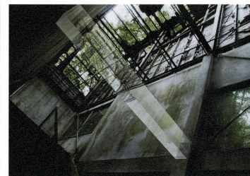
【低反射ガラス】を板けた屋根の下の梁材として使い、ガラス特有の降り注ぐ光の反射を抑えながら、建築を支える。
