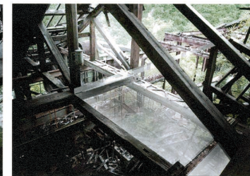
半透明な【すりガラス】を床材として使い、視線をさえぎりながら、やわらかい光を均一に取り入れる。
