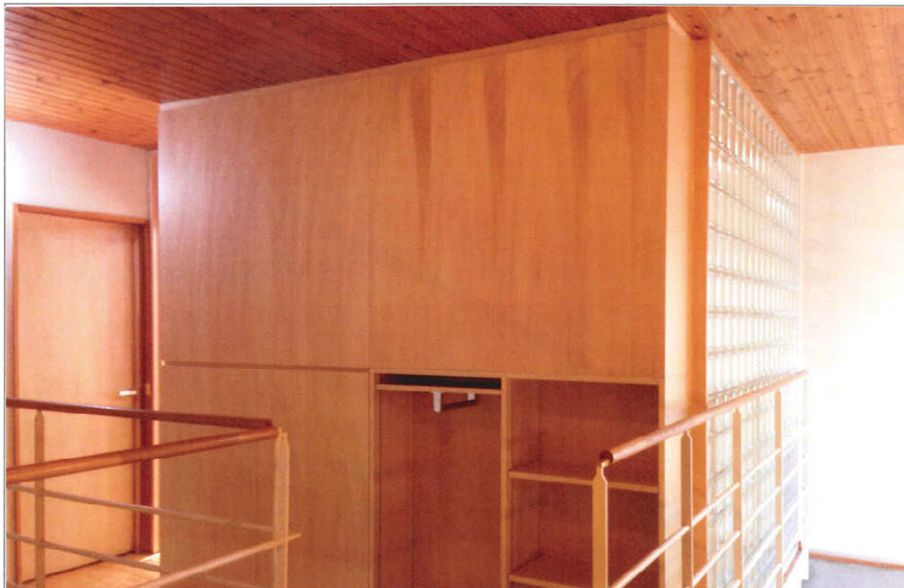
【外観】手摺に取り囲まれたスペースの内側に、収納家具とガラスブロックで部屋をつくる。
