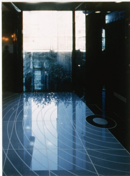
ホール床・裏面に流れる大横川の水面の波紋をイメージ。 (ネオパリエ・Sカラー・グレー、ブラック サンドブラスト・ノンスリップ加工)
