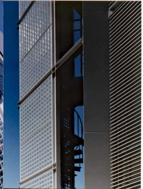
西面 階段部分
