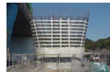
ARGファイバを使用した橋脚(建設中)
