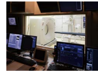
放射線遮へい用ガラスを使用したIVR-CT室
