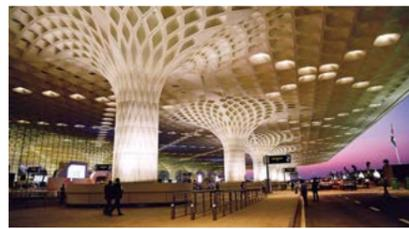
ARG纤维的应用示例:贾特拉帕蒂·希瓦吉国际机场(印度孟买)
